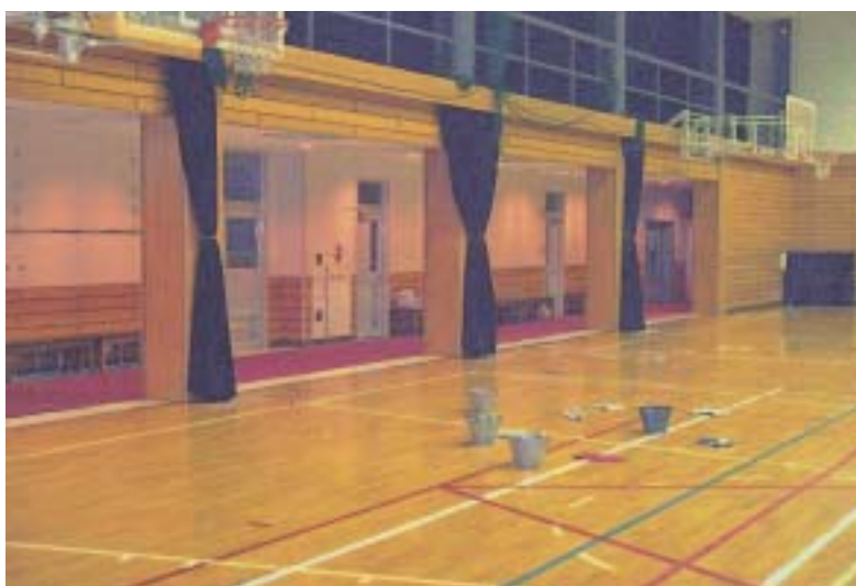
沢田中学校体育館内雨天時の状況
