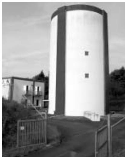
沢田地区簡易水道浄水施設配水池 (赤羽字長原地内)
