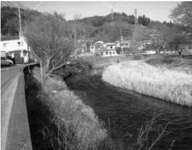
改修がもたれる重要水防区域 (字屋敷ノ入地内、北須川)
