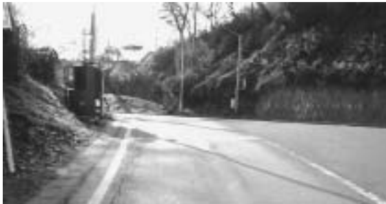
◀鹿ノ坂地内に設置されている凍結防止剤自動散布装置
