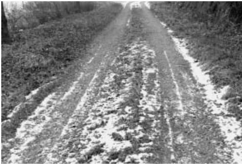
一部砂利道が残る千五沢ダム湖畔の道路
