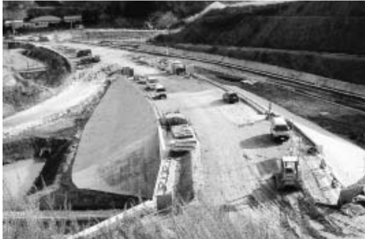
工事が進む仮称「飯野三春石川インターチェンジ」周辺の工事現場
