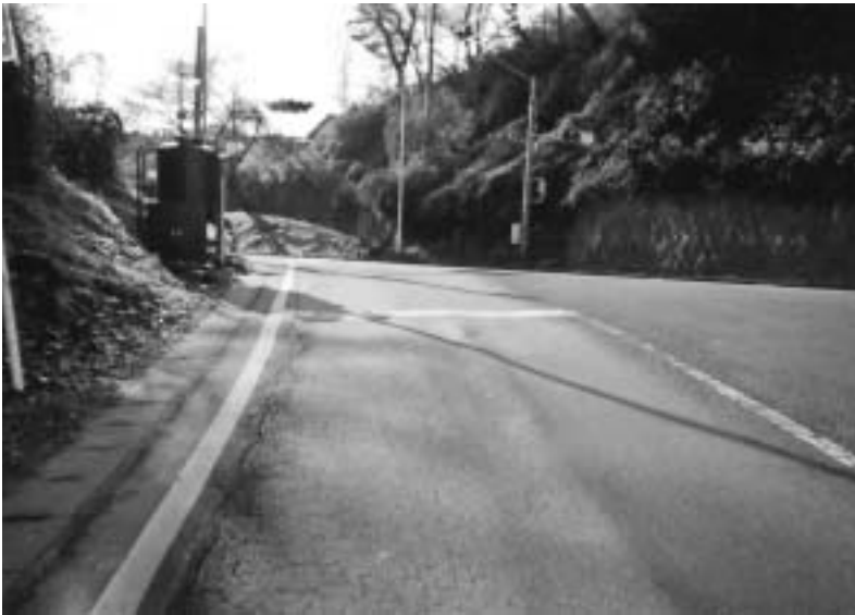
国道118号線に向けて設置してある凍結防止剤自動散布装置(字鹿ノ坂)
