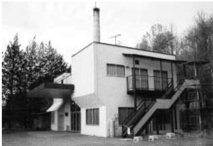
現在の火葬場、新火葬場完成後は、解体が予定されている（字長久保）
