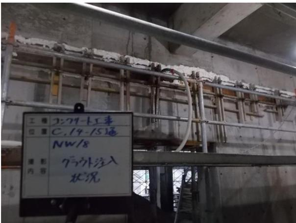
上記の耐震壁へのコンクリート打設後、上部隙間に、グラウトという隙間を埋めるための液体を注入し、耐震壁との一体化を図ります。
