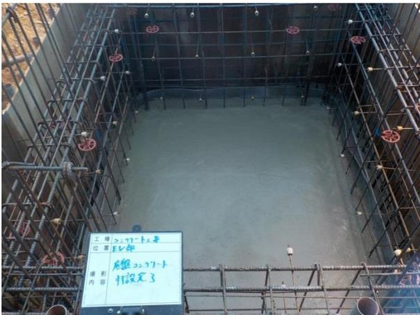
まず、底盤を先にコンクリートを打設します。
