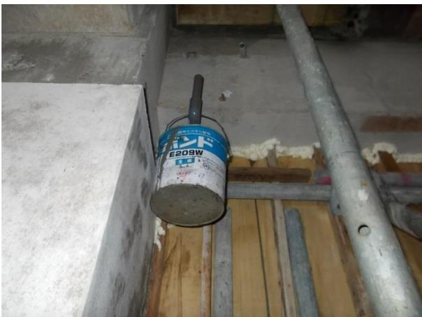
グラウト注入後、グラウトがオーバーフローしているため、隙間がなくなったことが確認できます。
