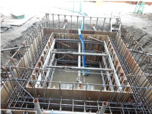
その後、基礎・型枠を組立て、もう一度コンクリートを打設し基礎工事が完了します。
