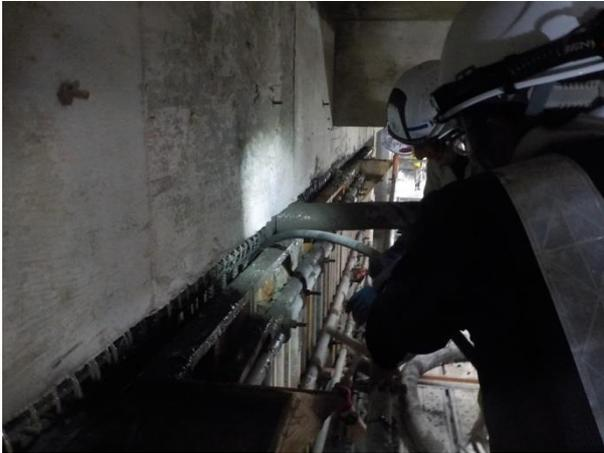
文教福祉複合施設の耐震壁となる壁に、コンクリートを打設しています。
