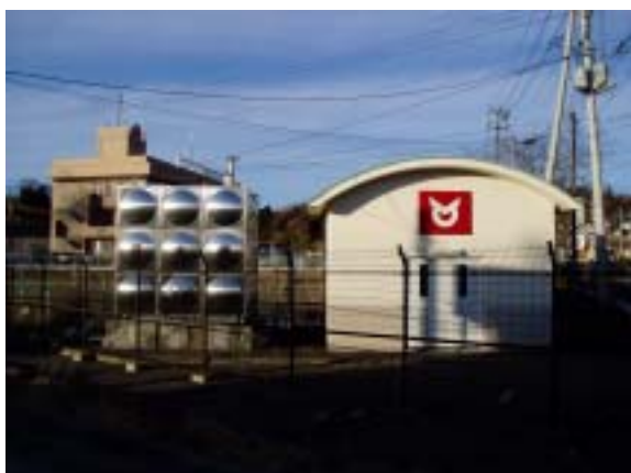
「長久保ポンプ場」
