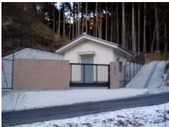
「豆ヶ平ポンプ場」
