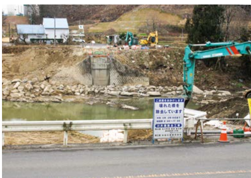
▲復旧が待たれる川井橋
