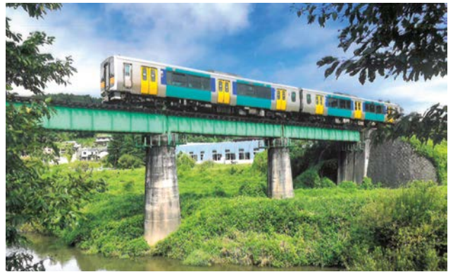
▲水郡線橋脚の堆砂状況(松木下地内)
