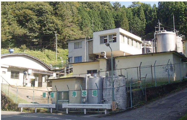
▲改修整備が待たれる母畑浄水場
