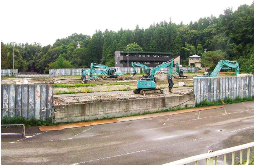
▲5階建て4棟が解体されました。9月4日撮影
