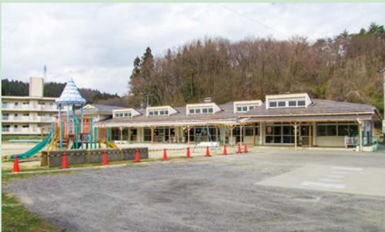
▲老朽化が進む第一保育所
