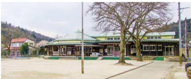
▲床上浸水の被害を受けた第二保育所
