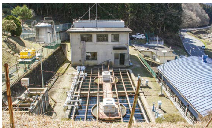
▲老朽化が進む母畑浄水場
