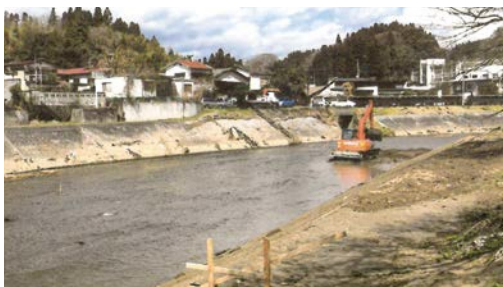
▲堆積した土砂の撤去状況
