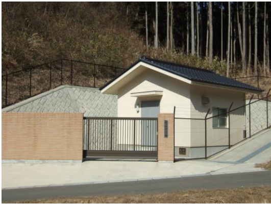
豆ヶ平ポンプ場
