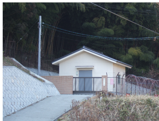
須沢ポンプ場
