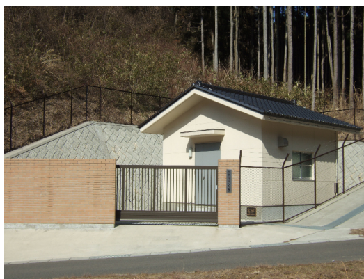
豆ヶ平ポンプ場
