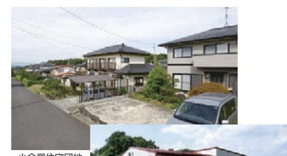
小金塚住宅団地
