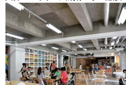
天井:コンクリート(既存スラブ補修)
