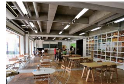
天井:コンクリート(既存スラブ補修)
