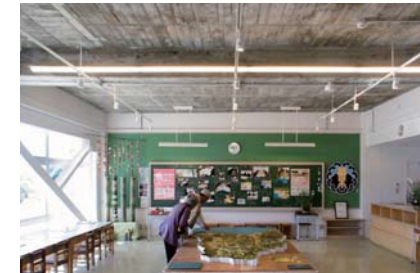
天井:コンクリート(既存スラブ補修)
